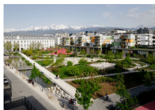
EcoQuartier de la ZAC de Bonne à Grenoble
